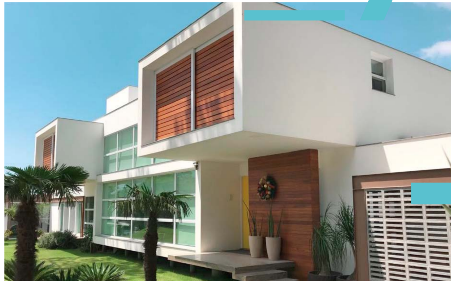
Projeto de residência às margens do Arroio Pelotas - Rudelger Leitzke
